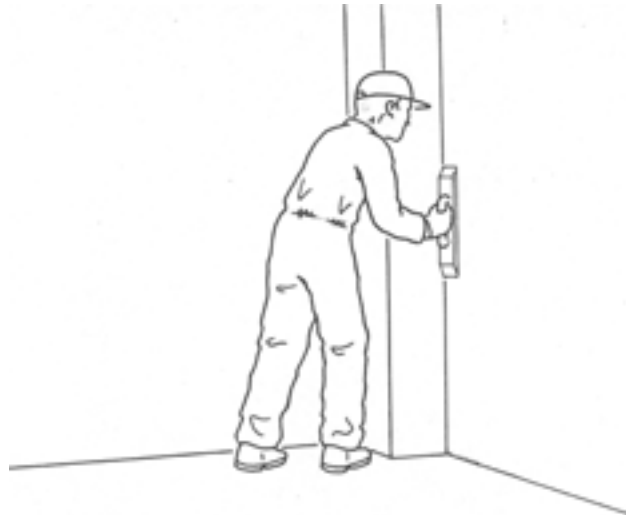
Fig 21. Relleno de esquinas contra miras
