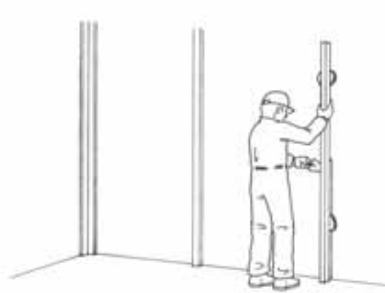
Fig 5. Ejecución de maestras
